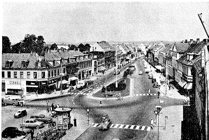
Den trekantformede del af Nørregade. Bilsporene viser det skarpe sving på 90 grader.
