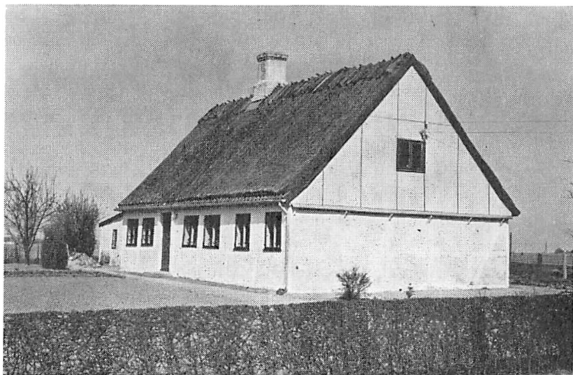
Niels Pedersens hus i Spjellerup, opført 1868. Vinduerne nye og gavltrekanter med ny beklædning. Foto 1971, Henry Rasmussen, Fuglebjerg.
