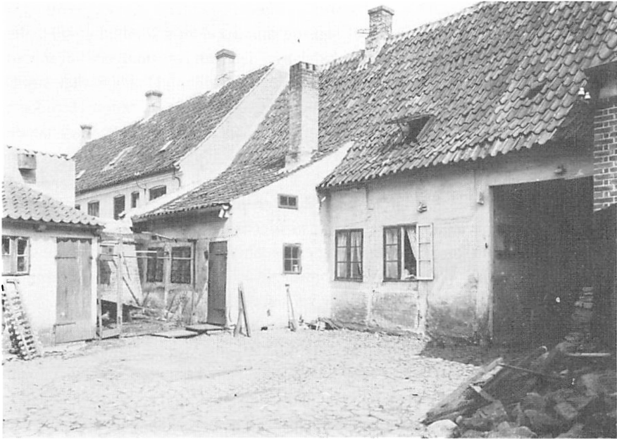
Bagsiden af forhuset i Algade 110B, Nationalmuseets 2. afdeling, Hugo Matthiessen 1913. Bemærk den lille 3-fags udbygning med egen skorsten. Sådanne bygninger (luder) var almindelige i danske købstæder i 1700-tallet, og her befandt køkkenet og bryggerset sig sædvanligvis.
