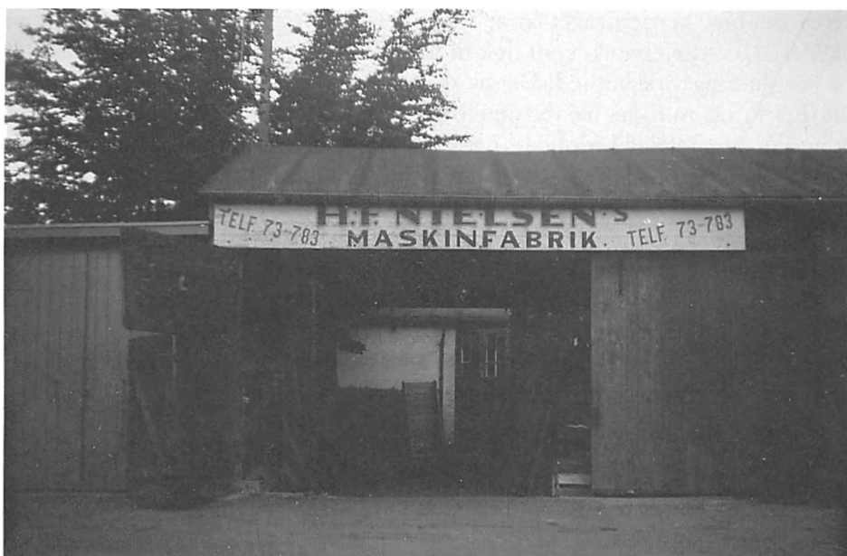
H. F. Nielsens Maskinfabriks facade mod Nørregade.
