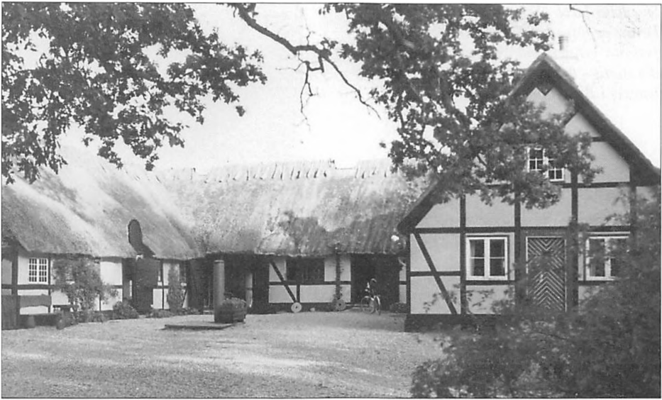
Bisserup Skovfogedsted, 09.1975. Det sydligste (på "fastlandet") af de endnu i 1910 i brug værende skovfogedsteder. - Nord- og østlængen er fra ca. 1780, mens stuehuset er fra ca. 1840.
