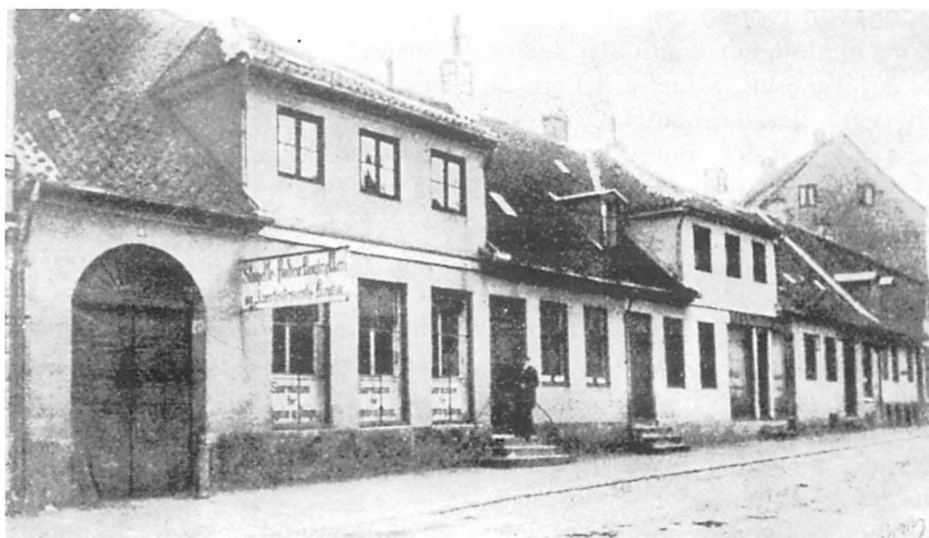
Ejendommen til højre for porten er Bredegade 6, Slagelse, som husede latinskolen i årene 1809-52. I stueetagen var der klasselokaler og på første sal rektorbolig. Efter latinskolens ophør havde ejendommen flere ejere og blev i 1902 revet ned til fordel for en sparekassebygning.
