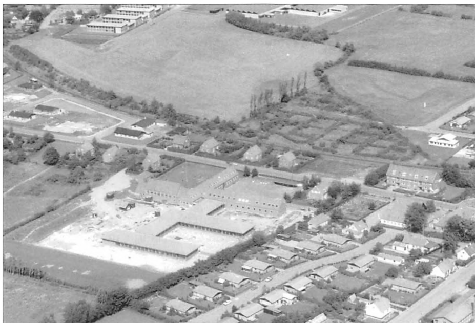
Luftfoto fra 1971. I forgrunden Marievangsskolen, der allerede er blevet udvidet nogle gange siden ibrugtagningen i 1954 (se illustration 5). Efter Marievangsskolen ligger der 3 lærerboliger på begge sider af Holmstrupvej. Længst til venstre er boligerne på Banehegn ved at blive bygget. Bag lærerboligerne kolonihaveforeningen Marievang og en beplantning, der bugter sig over arealet. Det er kommunegrænsen mellem Slagelse og Sct. Peders landsogn. Allerbagest den nyopførte tekniske skole ned mod Vestre Ringgade. Den lå i Slagelse kommune, mens kollegiet til venstre på Bredahlsgade lå i Sct. Peders landsogn. I dag ligger Slagelse gymnasium, Selandia m.v. på arealet. Foto i forfatterens eje.
