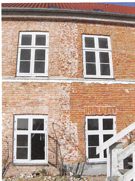
Fig. 5. Udsnit af havefacaden til Kruusesmindes hovedbygning. Efter fjernelse af pudslagene trådte der ganske overraskende en tydelig skillelinje i murværket frem, som kun kan forklares med en forlængelse af bygningen. Fot. Helge Torm d. 25. februar 2008.
