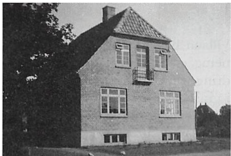
Molbechs Allé 14, fotograferet lige efter opførelsen i 1932. Foto i privat eje.
