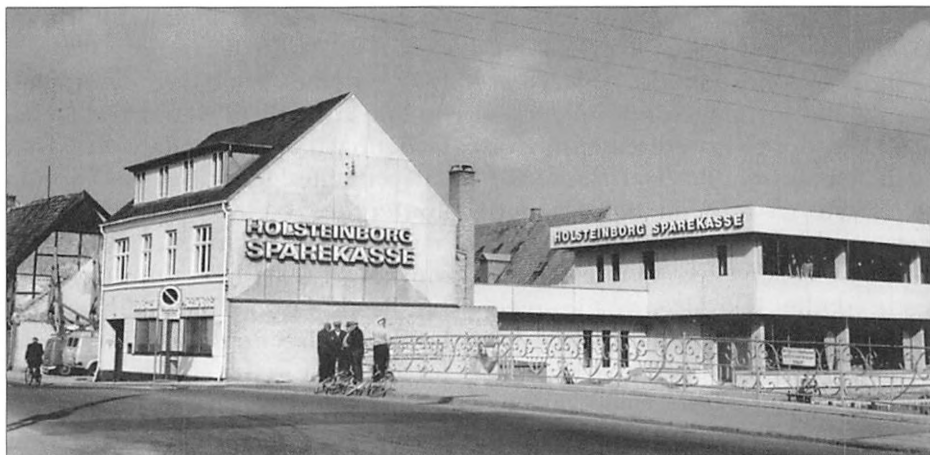
Her ses både Skælskør-filialens tilholdssted fra 1957-71 på Vestergade 4 og den ny bygning bagved, som skulle rumme selve hovedsædet for Holsteinborg Sparekasse og gjorde det fra indvielsen i september 1971 til 1. januar 1989. Det gamle hus, vel opført i sidste halvdel af 1800-tallet, måtte lade livet, da funktionerne her pr. september 1971 kunne rykke over i nybygningen. Denne rummer efter en "ansigtsløftning" sidst i 1990'erne Skælskørs kommunale bibliotek. Foto v/Sterling Foto, Skælskør, fra foråret 1971. Venligst udlånt af grev Ulrich.
