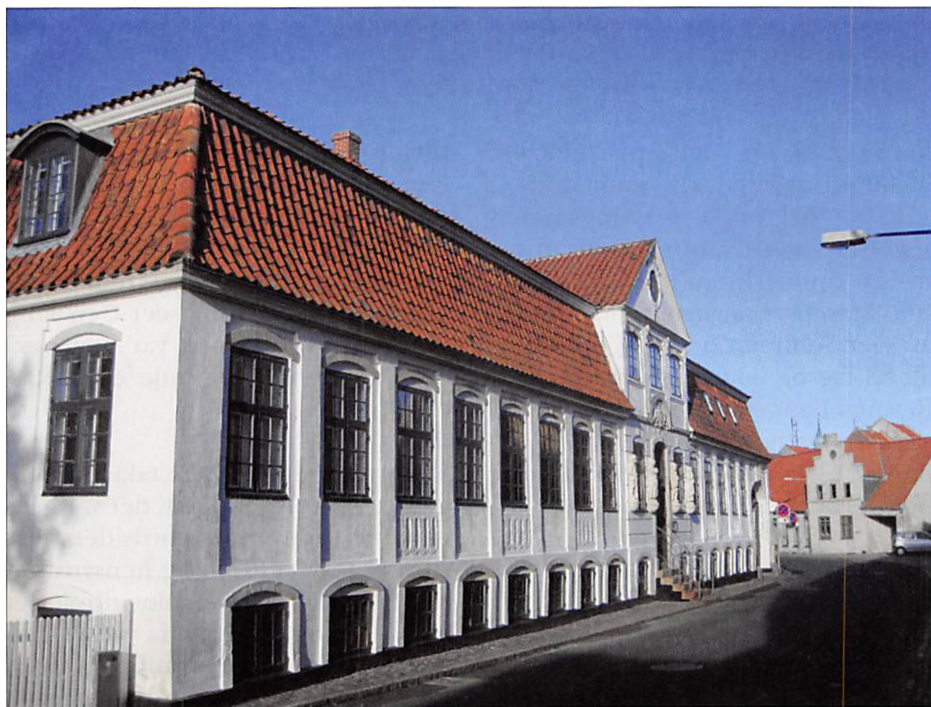
Den nu velholdte Kongegaardens hvidkalkede facader lyser godt op i gadebilledet. Foto: Helge Torm den 20. okt. 2010.
